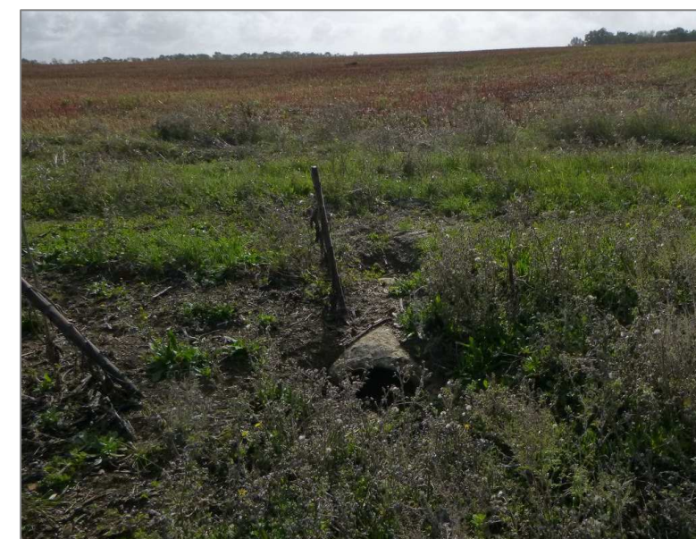
Photographie 4 : Ancien fossé de drainage et buse (au centre) au niveau de l'implantation de l'éolienne E1
