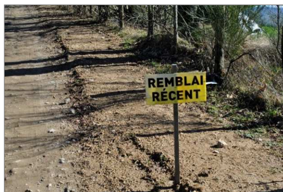
Photographie 5 : Exemple de remblai des tranchées électriques le long d'une piste
